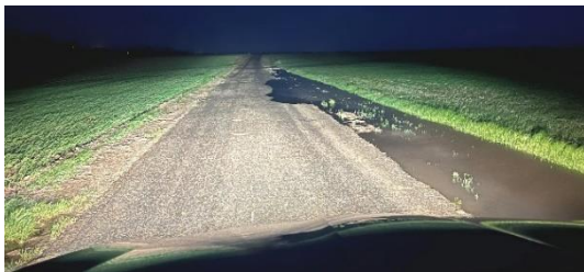
route inondée 17 novembre 2022
